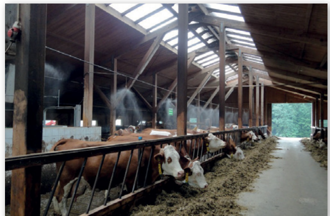
Abbildung 13: Beispiel für ein Hochdruckvernebelungssystem (Quelle: Zahner)
