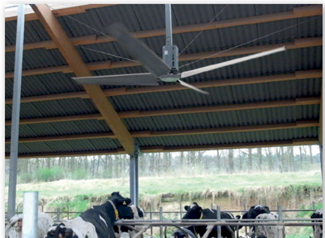
Abbildung 7: Typische Anordnung von Deckenventilatoren (Quelle: Pelzer)
