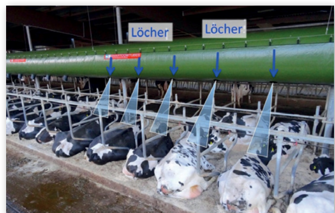
Abbildung 10: Funktionsprinzip Schlauchbelüftungssystem (Quelle: VET.SMART GmbH)
