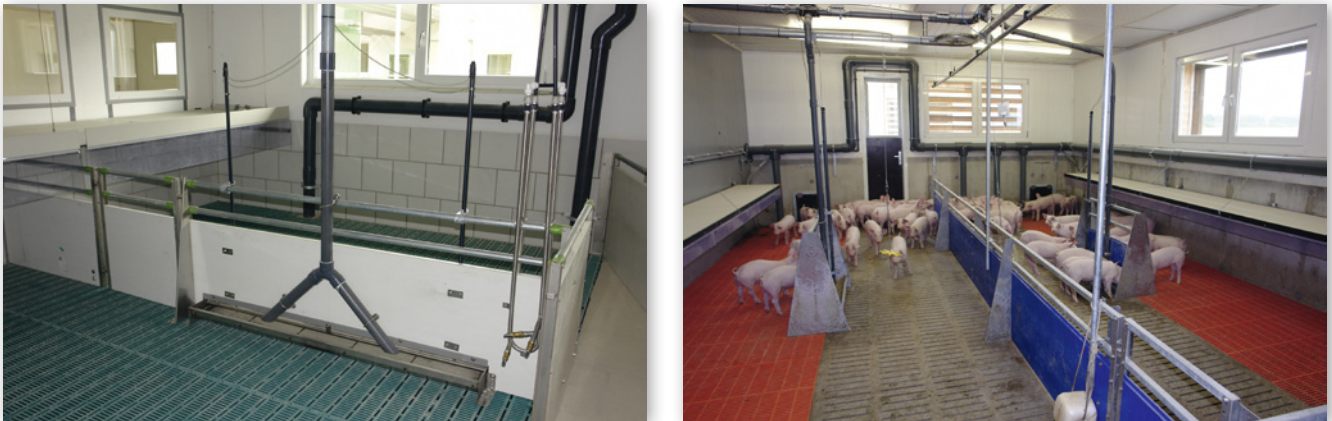
Abbildung 7: Varianten der Ausdosierung von klassischen Flüssigfütterungsanlagen (Quelle: Dr. Weber)
